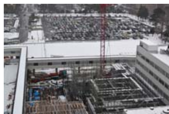
図15 分子追跡陽子線治療施設の建設風景(平成24年2月)
