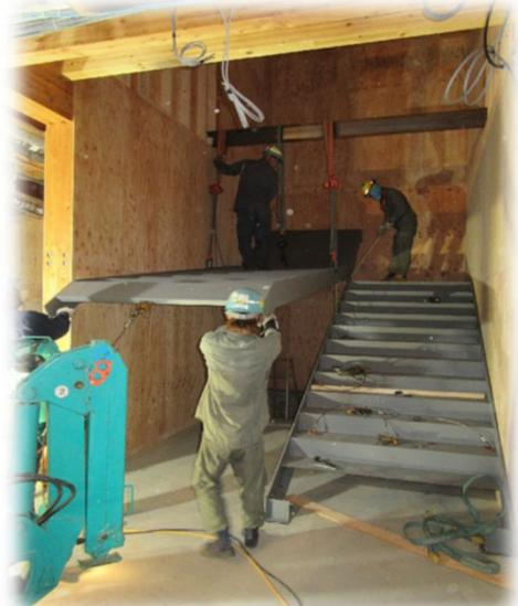
鉄骨階段の設置が完了しました。踏板に修正材を張ります。
