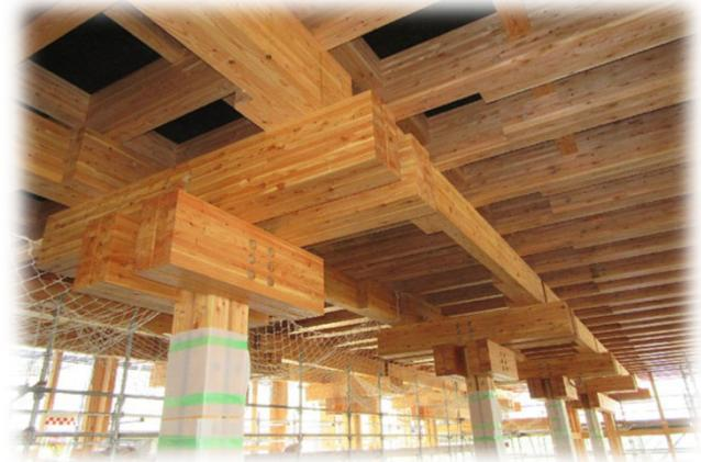
**屋根の木下地板張りが完成しました。この上に、断熱材・防水材・仕上材を設けます。今回の柱頭と梁には集成材のクリア塗装仕上げとし、映えるよう、木下地板はつや消しの黒としました。**
