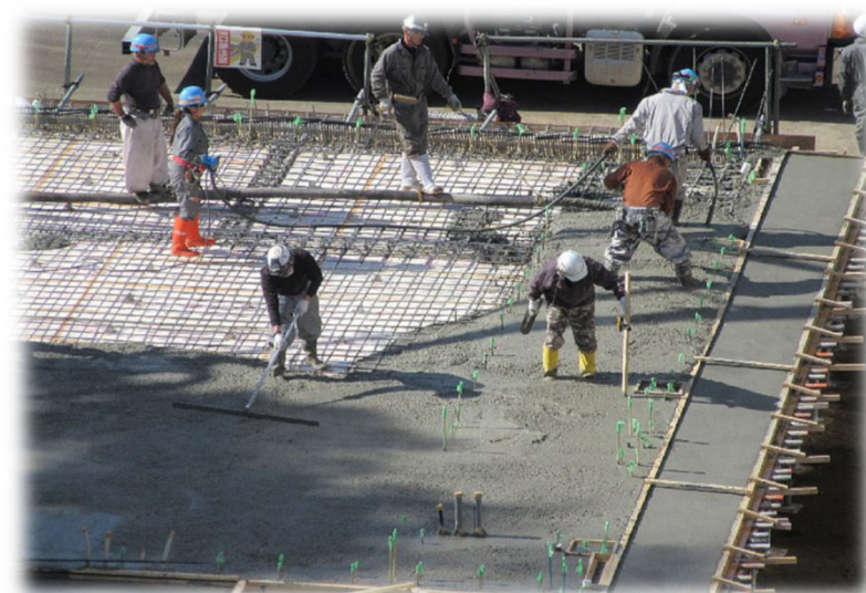
コンクリート打設の様子
